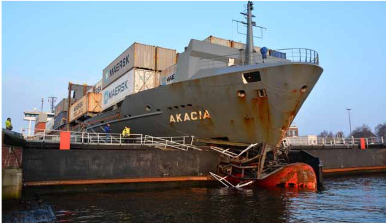
Maximale Schleusenbeschädigung im Februar 2018
